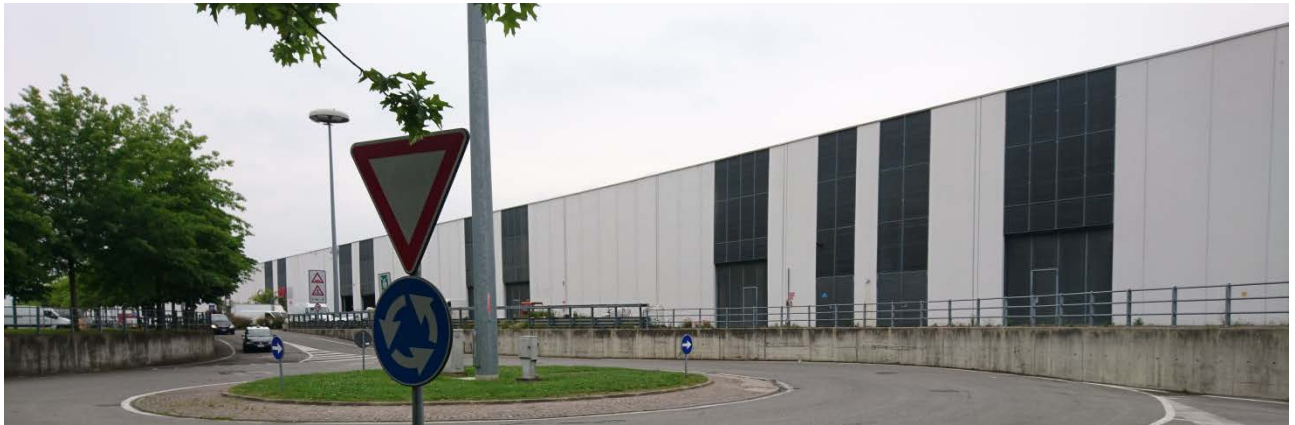
Vista facciate edificio F11
