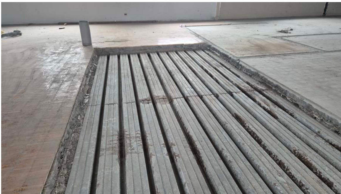
(fig. 1: l'impalcato esistente in lamiera grecata)
