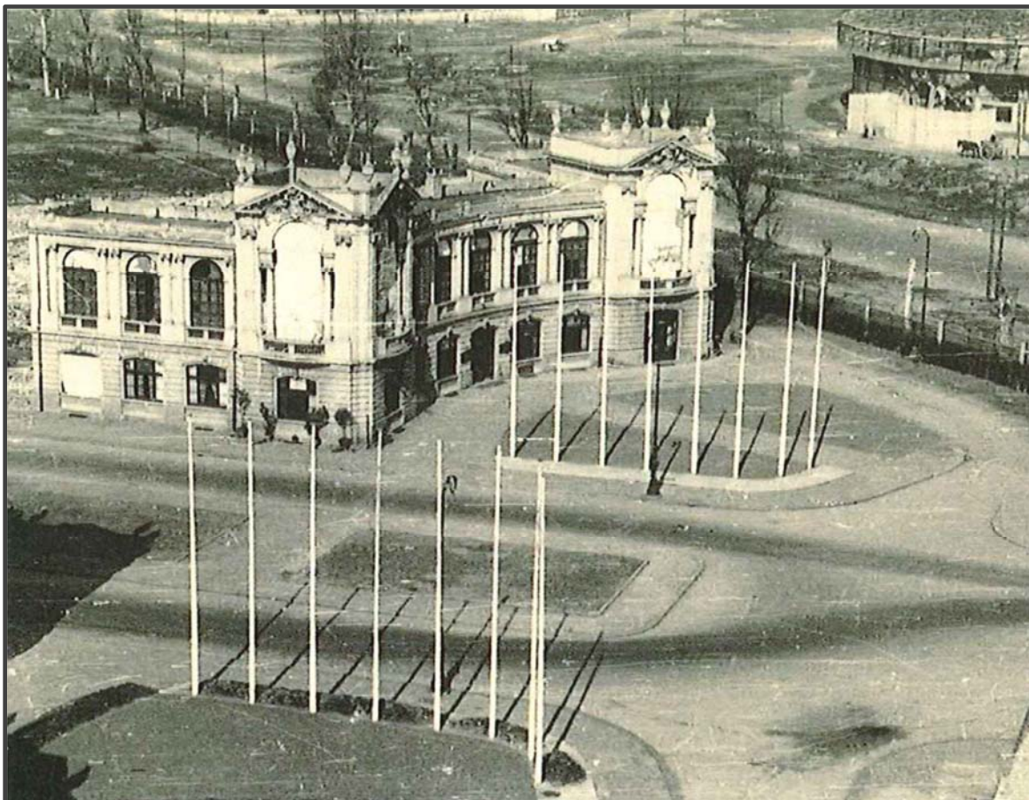
La recinzione della Palazzina A su Viale Duilio nel secondo dopoguerra
